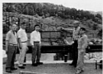
鉄橋落下の事故現場を視察中
